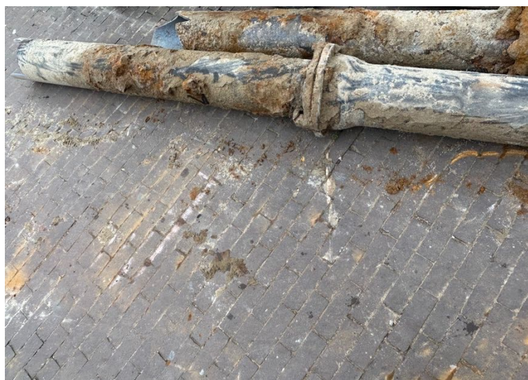
gietijzeren rioleringsbuizen keizersgracht
